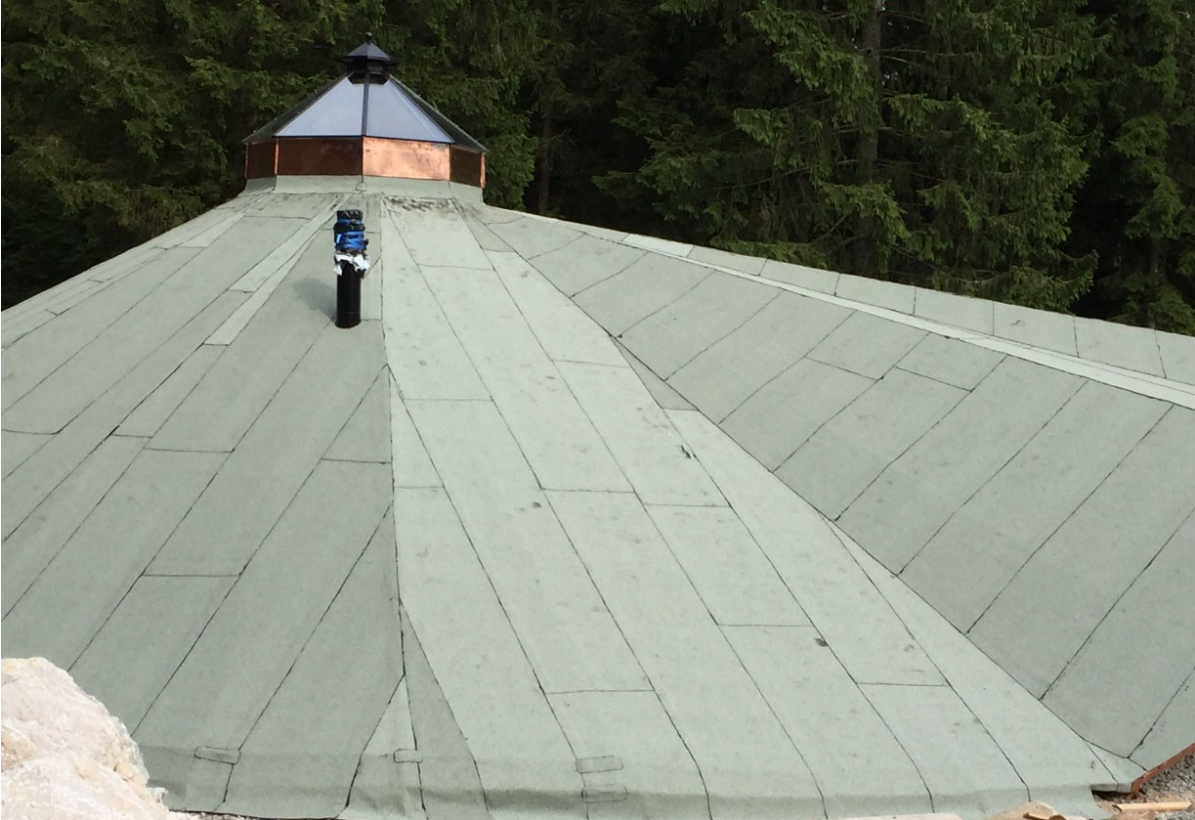
Der Dachaufbau mit Lichtkuppel
