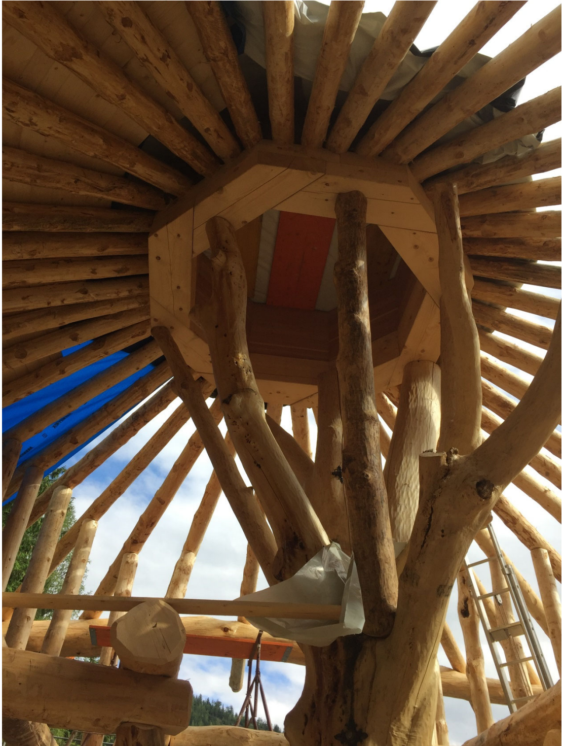
8-eckiger Pfettenaufsatz als Auflager für die Lichtkuppel
