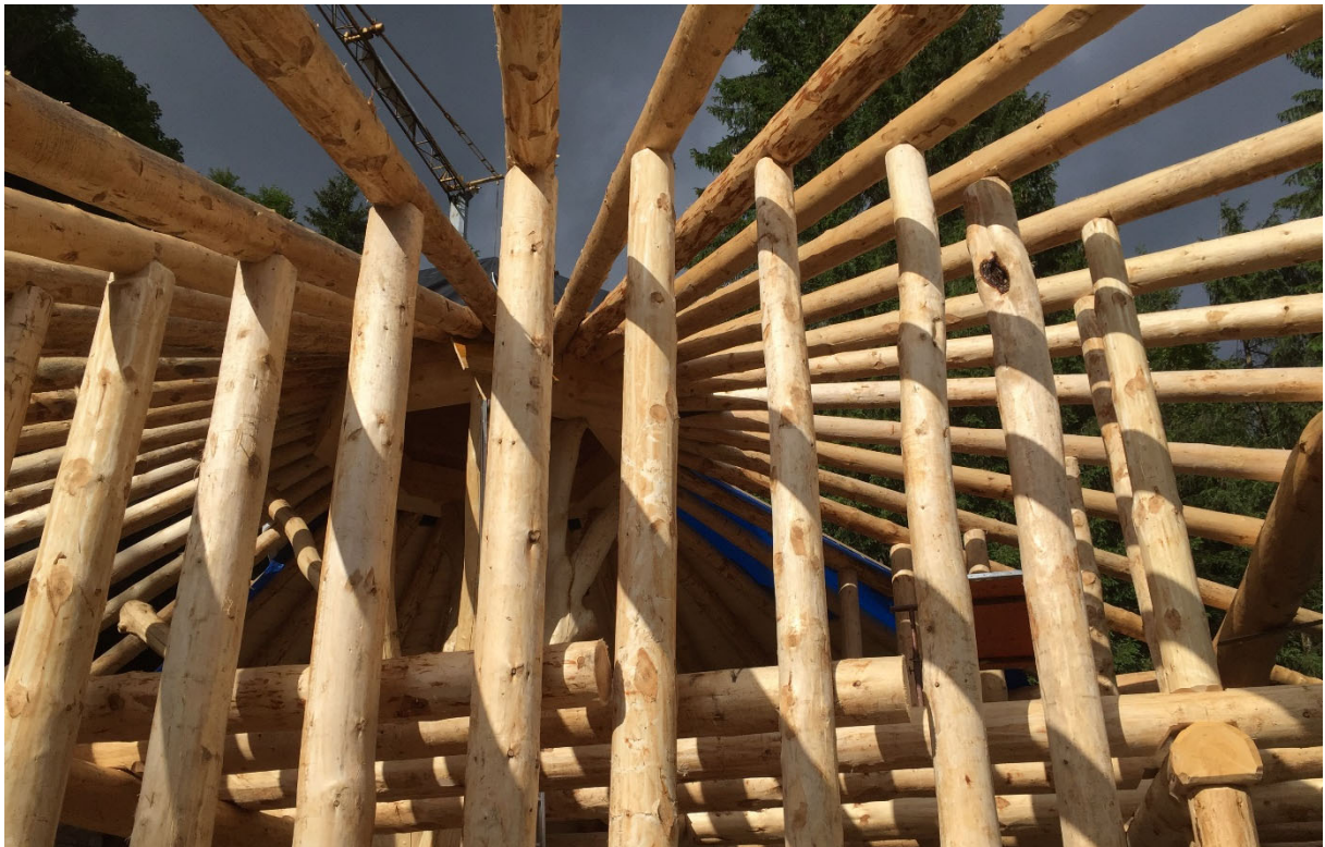
Jeder Sparren wird mit einem eigenen Baumstamm gestützt
